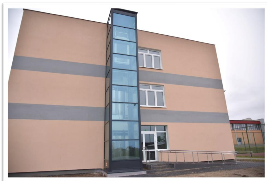
ZDJĘCIE: SZKOŁA PODSTAWOWA W KROKOWEJ – ODNOWIONY SEGMENT Z WINDĄ
