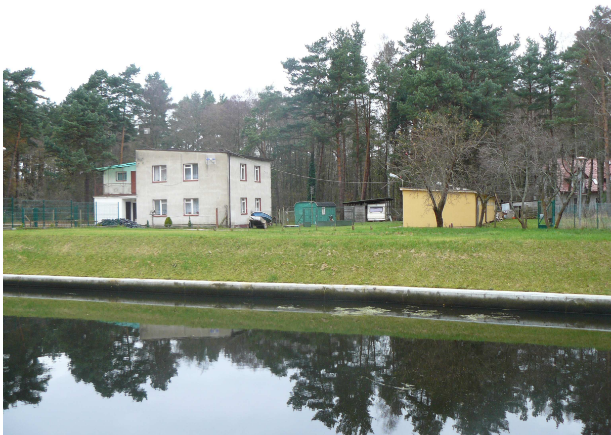
Zdjęcie 2. Obszar objęty projektem planu – teren stacji pomp (budynek mieszkalny)
