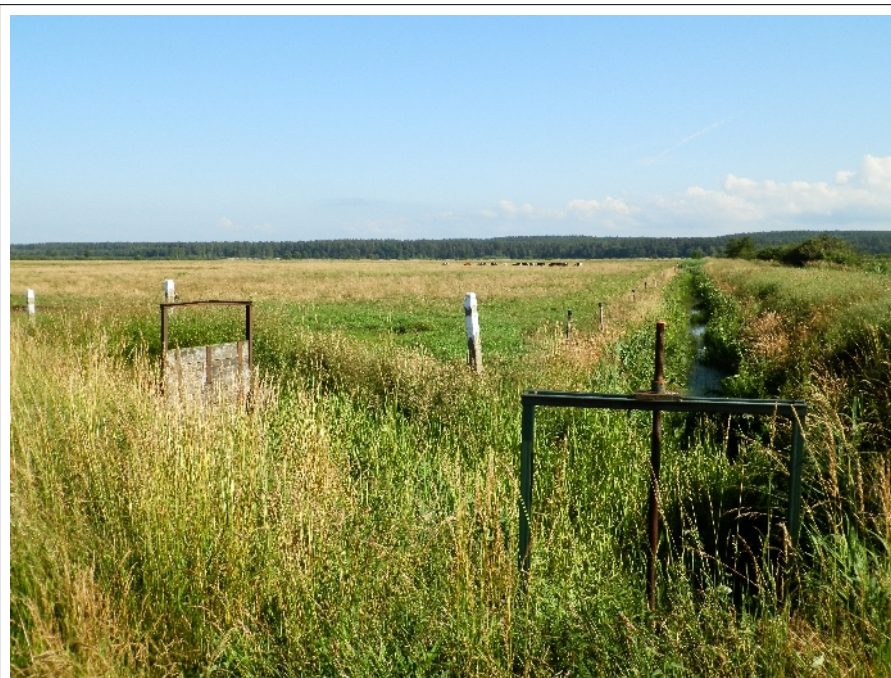
Ilustracja 3: Kanał melioracji wodnych podstawowych A-I (po prawej, na wprost) i szczegółowych A-90 (po lewej) wraz z urządzeniami.
