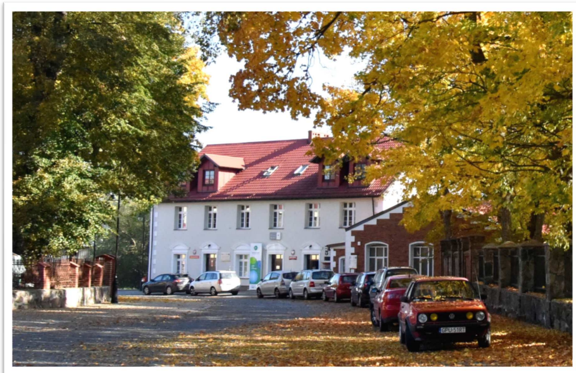
Odnowiona elewacja budynku poczty i muzeum po termomodernizacji
