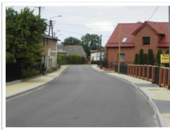
Droga i chodnik w Sławoszynie
