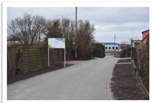
Ulica Ogrodowa w Żarnowcu
